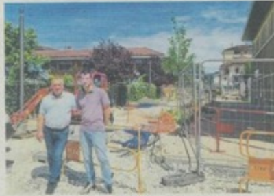
Serge Bernard-Granger et Édouard Perretier devant le chantier de la rue des Écoles, qui sera terminé fin août. Photo Le D.L.A.H.
