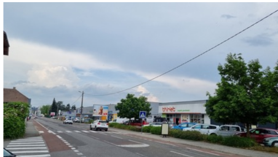
Bâtiments en « boîtes à chaussures », zone d'activités commerciales au sud de Rumilly
