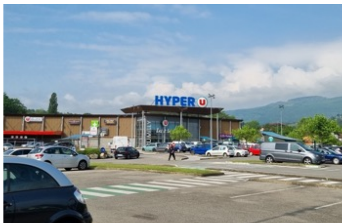
Enseigne sur toiture en lettres découpées, Rumilly
