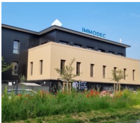
Enseigne sur toiture en lettres découpées, Rumilly
