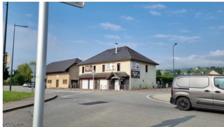
Enseignes parallèles au mur, activité isolée, Bloye
