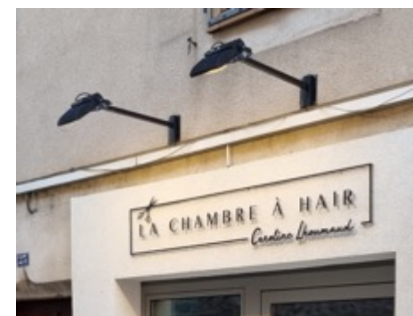
Enseigne lumineuse éclairée par des spots, Rumilly
