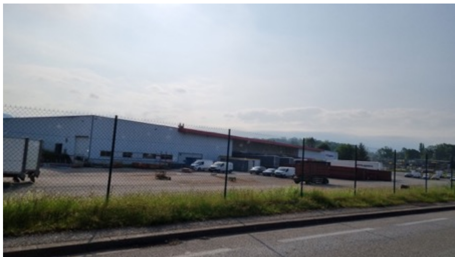
Enseigne parallèle au mur, Marigny-Saint-Marcel
