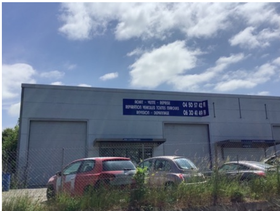
Enseigne parallèle au mur, Vallières-sur-Fier
