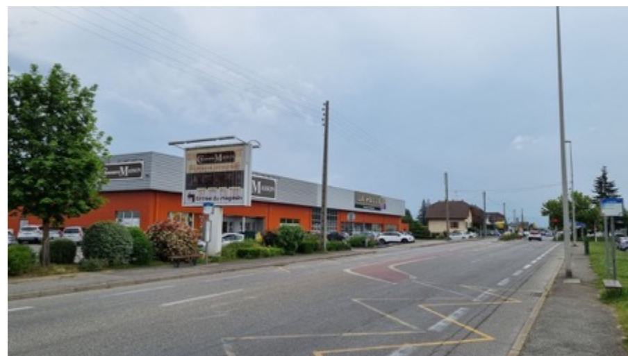
Large voirie, Zone d'activités commerciales au sud de Rumilly
