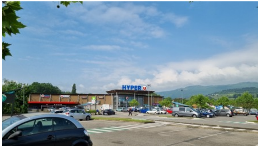
Enseigne sur toiture et enseignes parallèles au mur, Rumilly
