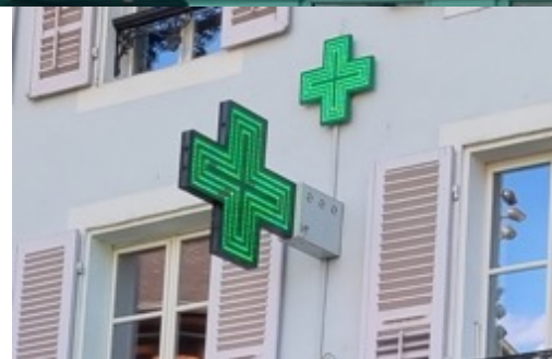
Enseignes lumineuses éclairées par des LED, Rumilly
