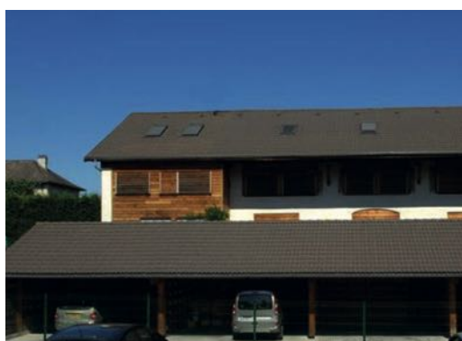
Ferme des Grumillons, Rumilly Architecte : Team Design
